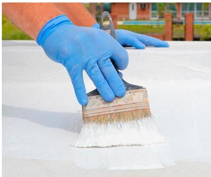
\* Introducir a continuación, una fibra de malla mat 100 o caucho fibrado. Terminar el proceso con una capa de caucho sin diluir. En total debe de ser 2Kg/m<sup>2</sup> de producto.
